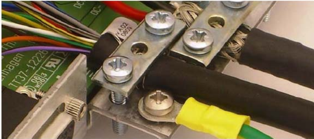
Рисунок 9. Фиксация кабеля приёмопередатчика.
